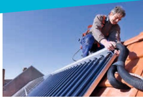
„Solarthermie“ nutzt die Energie der Sonne zur Warmwasserbereitung im Haushalt, aber auch zur Unterstützung der Raumheizung. Es wird also kein Strom sondern Wärme produziert. Solar Kollektoren auf dem Dach leiten die Wärme in einen Pufferspeicher, der sie an den Trinkwasserkreis oder das Heizungssystem weitergibt. Durch eine Solarthermie-Anlage können mit vergleichsweise geringen Kosten erhebliche Mengen an fossilen Brennstoffen eingespart werden.
